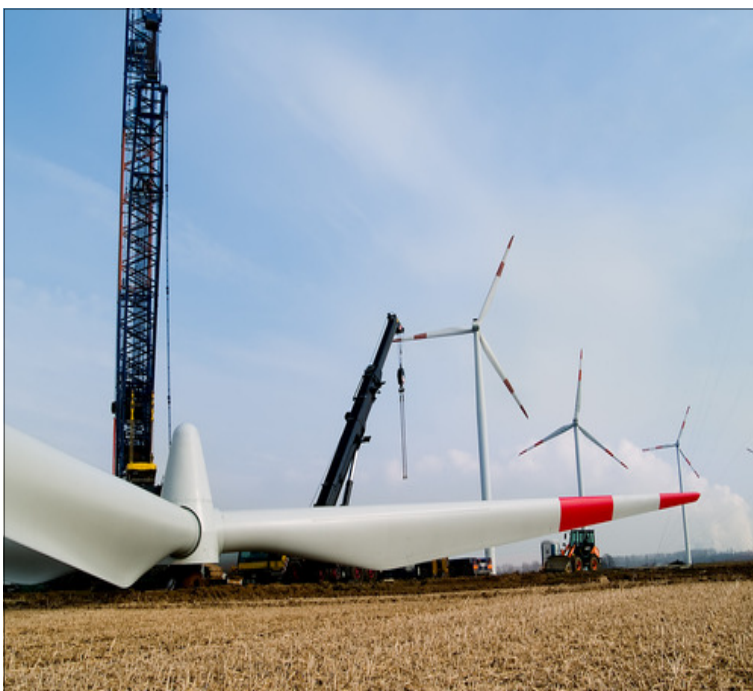
Figuur 4. Wind Turbine Draaivlerk en Vleuel Tydings Samestelling
